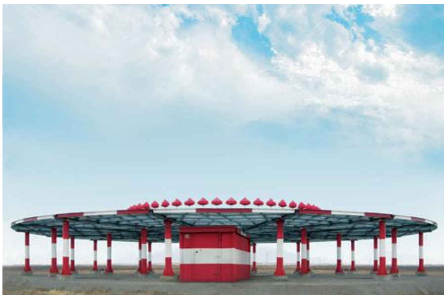
Рис. 5.6. Радиомаяк азимутальный доплеровский DVOR -2000 (Россия)
