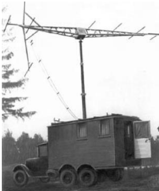
РЛС дальнего обнаружения РУС-2 (Редут) излучающая установка
