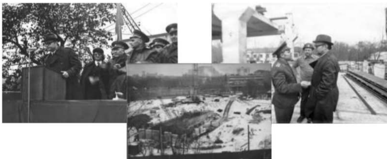
Начальный этап строительства Центра
